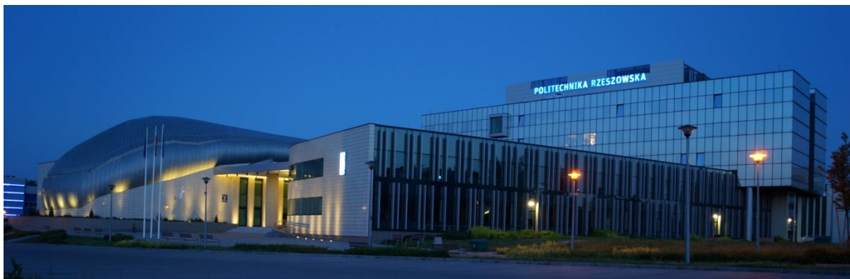
Rys. 8 – Flagowy budynek „V” Politechniki Rzeszowskiej
